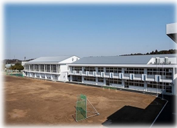
体育館と特別教室棟
