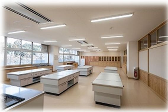
様々な実習に便利な広い家庭科室
