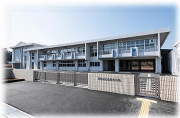
正面玄関からピロティーを臨む
