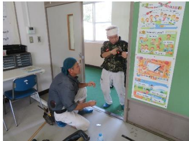
「あすなろ教室引き戸修理」
