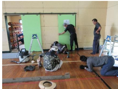
「体育館引き戸修理」
