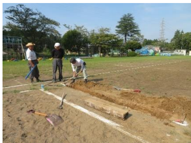
「走り幅跳び用踏切板交換」
